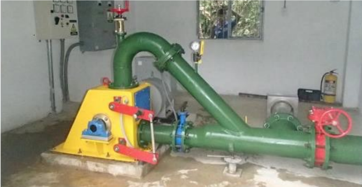
Turbina Pelton de dos chorros instalada en El Yuca, Comunidad Embera, Río Panguí, Nuquí, Chocó. Sirve para electrificar una comunidad indígena de 130 viviendas. Potencia 17 KW, Cabeza 60 m, caudal 50 l/s.
