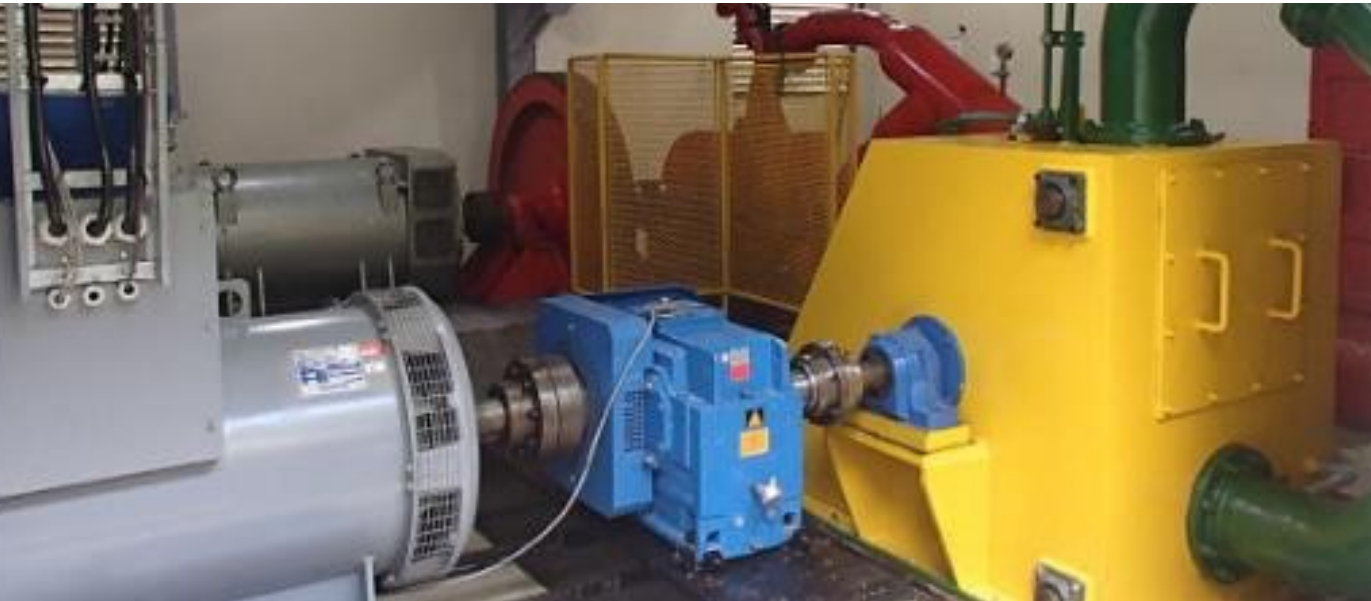
Turbina Pelton de dos chorros instalada en Palmar, Ciénaga, Magdalena. Opera en paralelo con otra turbina pelton de similares características y proveen energía al poblado de Palmor. Proyecto iniciado hace 25 años, y repotenciado por el Programa de Energía Limpia Para Colombia de USAID en 2016. Lo opera una empresa comunitaria de servicios públicos, Electro Palmor.
